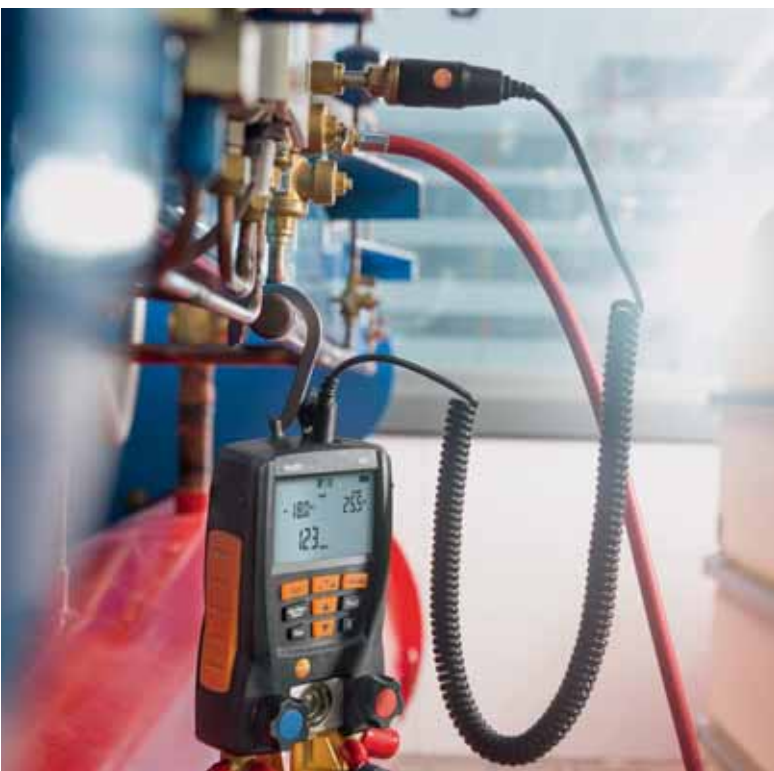
Medición de vacío de alta precisión: testo 557 con sonda externa.
